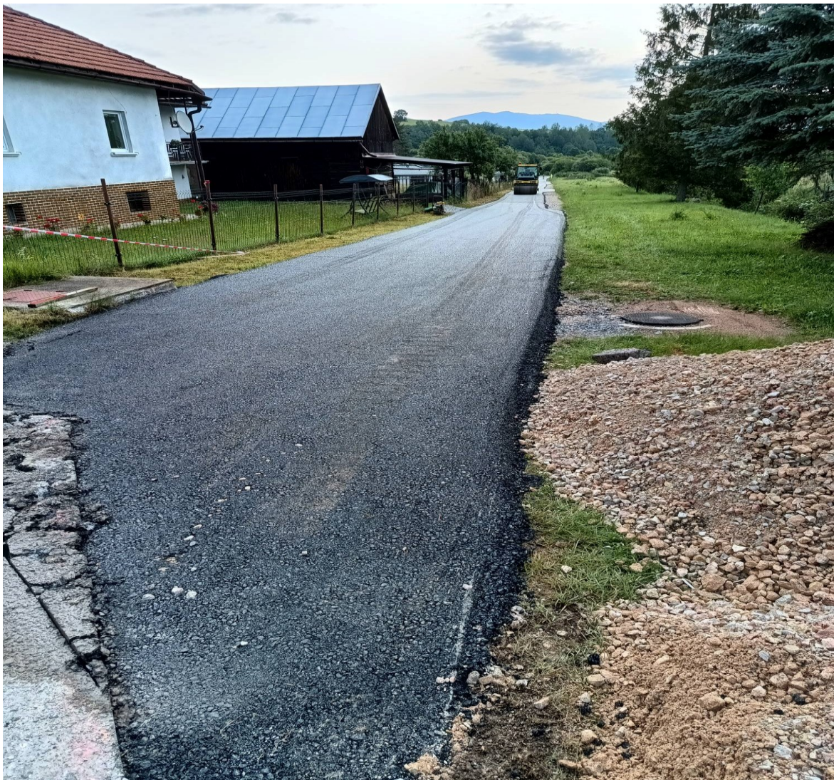
Obr. 3 Výstavba miestnej komunikácie k ČOV
