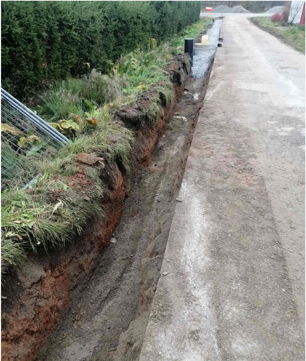
Obr. 2 – Stavba kanalizačného prepoja ulíc Hlavná a B. Němcovej
